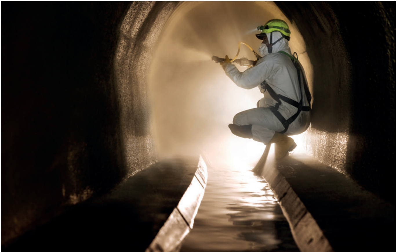
Beschichtung im Nassspritzverfahren
