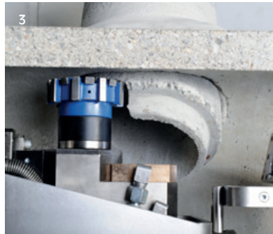
1+2 Verspachteln von Rissen 3+4 Einsatz eines Fräsroboters
