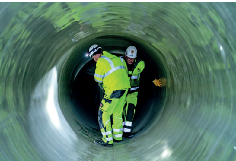
Mittels UV-Licht-Technologie ausgehärteter GFK-Liner
