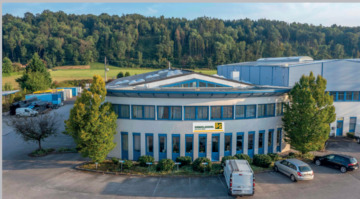
Bürogebäude, Werkstatt und Lager der D&S Austria in Pucking.
