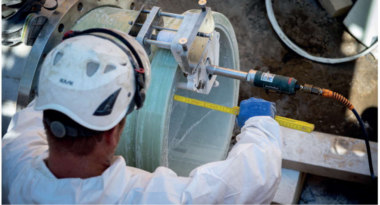
Einbau eines glasfaserverstärkten Epoxidharzflansches
