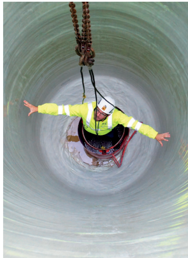
Mit UV-Licht ausgehärteter GFK-Schachtliner
