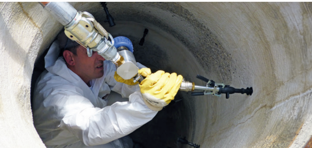
Durchführung einer Injektion im Schacht
