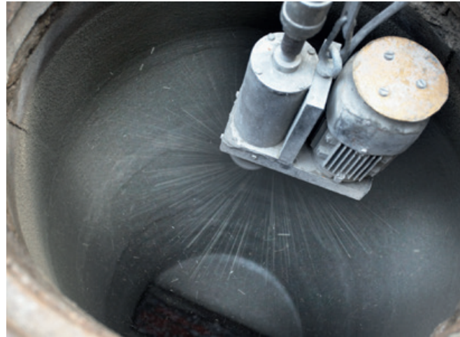
Schachtbeschichtung im Anschleuderverfahren
