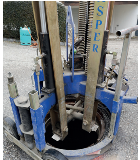
Neu-Positionierung eines Schachtrahmens
