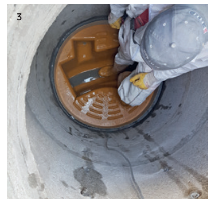
1, 2, 3 Einbau des sogenannten Flex-Liners zur Sanierung eines defekten Schachtgerinnes
