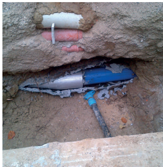
Ersetzen einer AZ-Trinkwasserleitung mittels Berstlining
