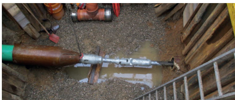
Einbringen des Berstwerkzeuges (Berstkopf mit Berstgestänge)
