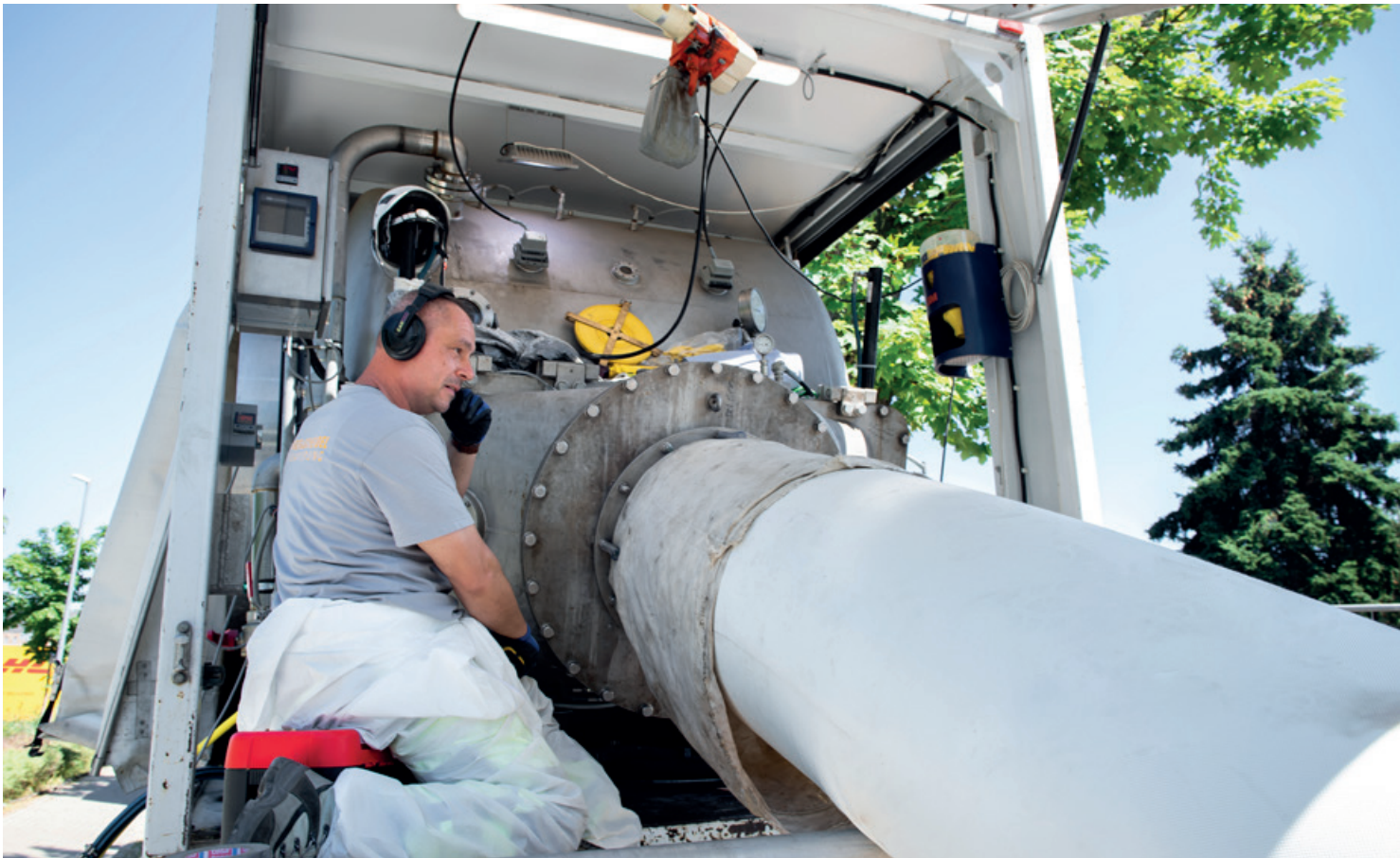
Inversion des Liners mittels Drucktrommel
