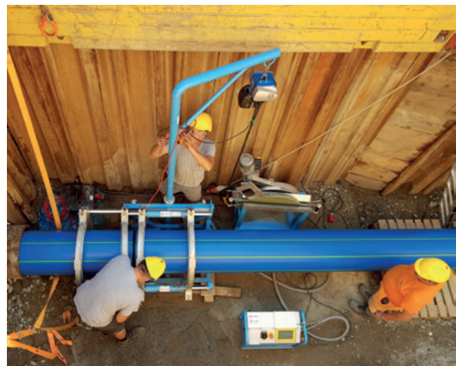
Stumpfschweißung und Einzug PE-Rohrstrang
